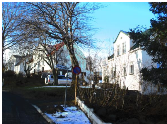
Mynd 22. Hamarstígur 2-6. Ljósmynd B.J.
