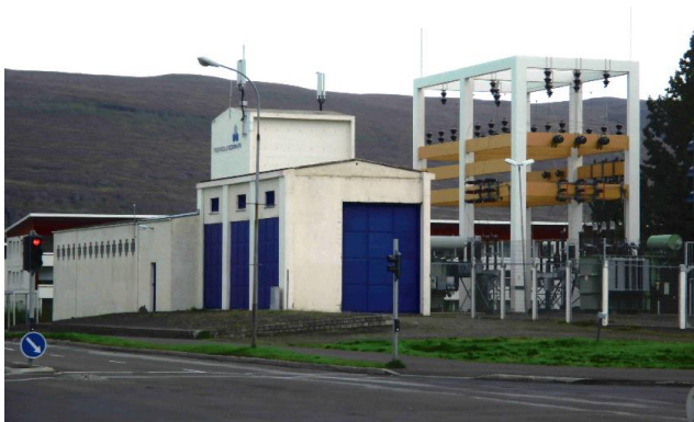
Mynd 31. Spennistöð Akureyrar. Arkitekt Sigvaldi Thordarson. Ljósmynd B.J.
